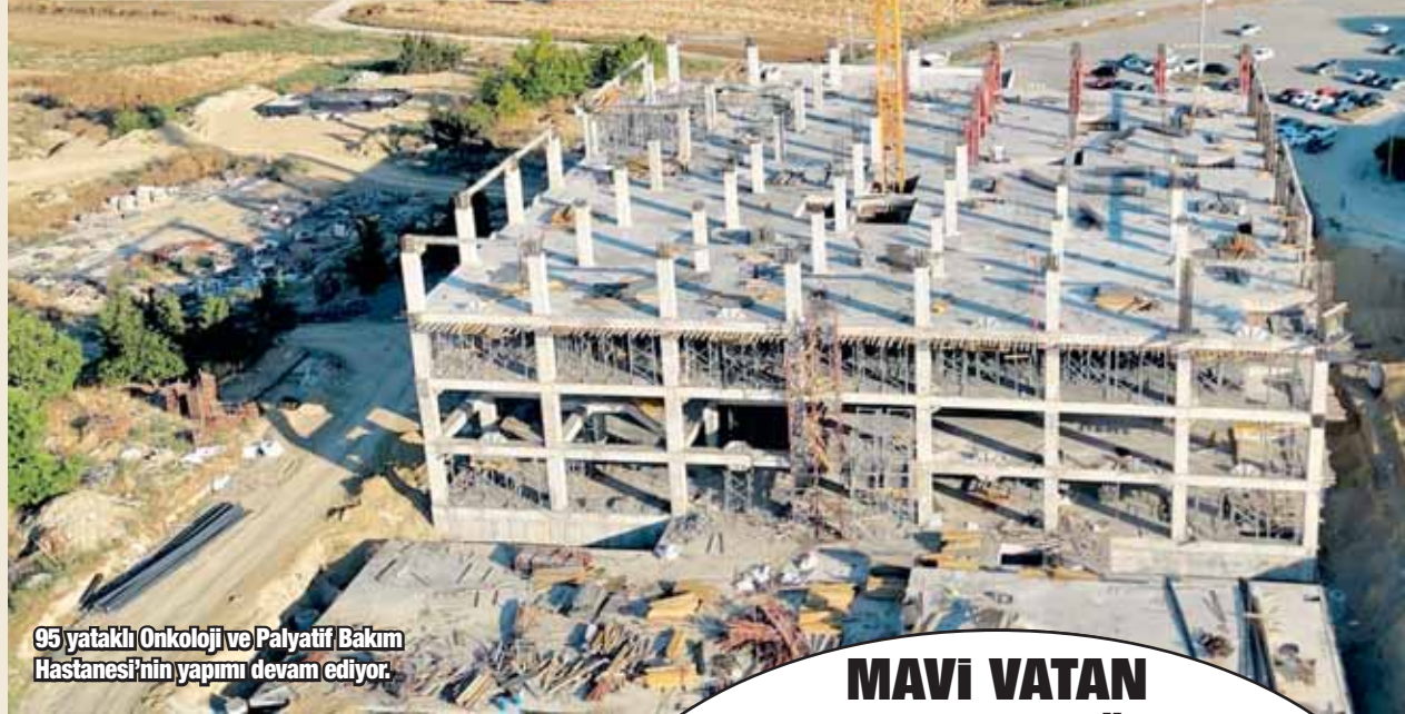
Barbaros Denizcilik Meslek Yüksekokulu inşaatında çalışmalar hızla yükseliyor.
